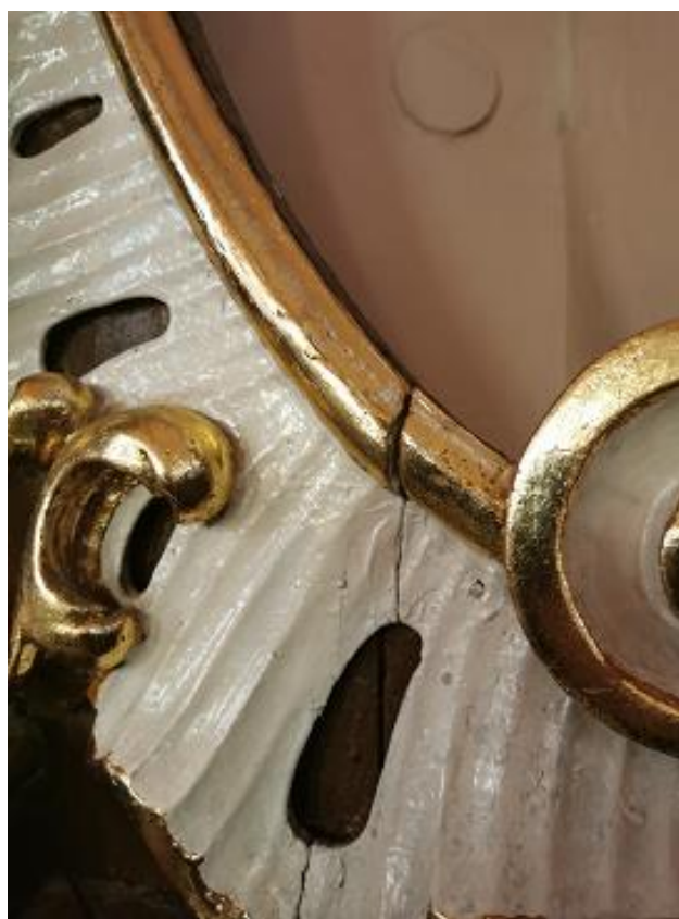
Spękania z przemieszczeniem konstrukcji architektonicznej ołtarza.
